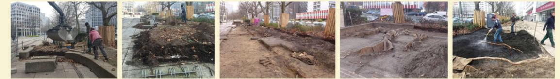
Fotos vorgezogene Baumaßnahme: Abriss der baufälligen Aufkantung, Freilegung und fachgerechte Sicherung der Baumwurzeln als Grundlage für weitere Planung
