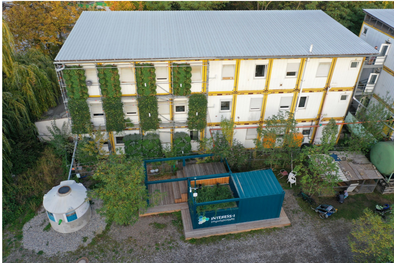
Impulsprojekt mit Pflanzenkläranlage, Zisterne, Vertikalgrün Quelle: Bernd Eisenberg
